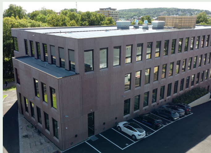
Tinghuset er bygd som passivhus, og det solceller på taket.
